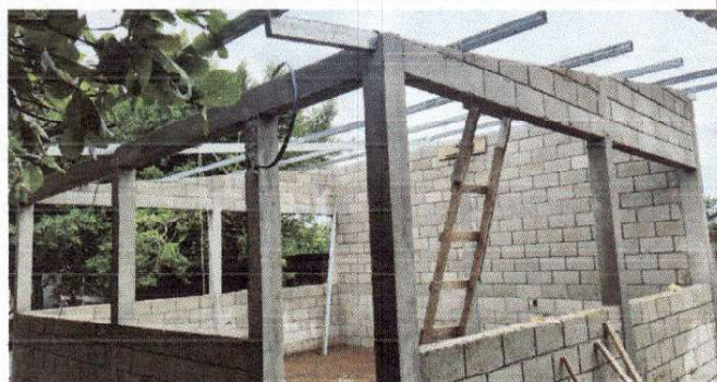
Foto1: Cambio de muro de lamina por muro de block
