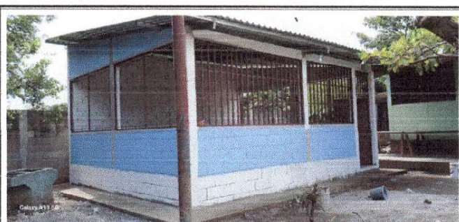
Foto 6: Proceso de pintura de interior y exterior
