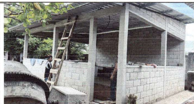
Foto 5: Proceso de cambio de piso de cemento liquido
